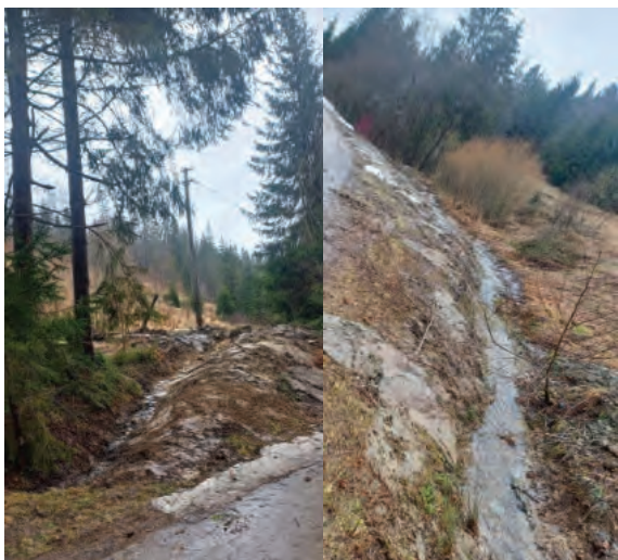
Úprava rigolov - časť obce - Chmúrovia
